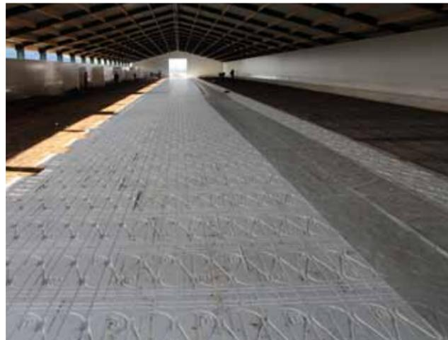
Verlegung im gesamten Stall unter der Betonsohle
