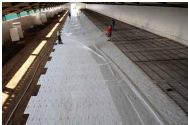
Ausbreitung der IN-PE-Folie über den IN-Dämmelementen
